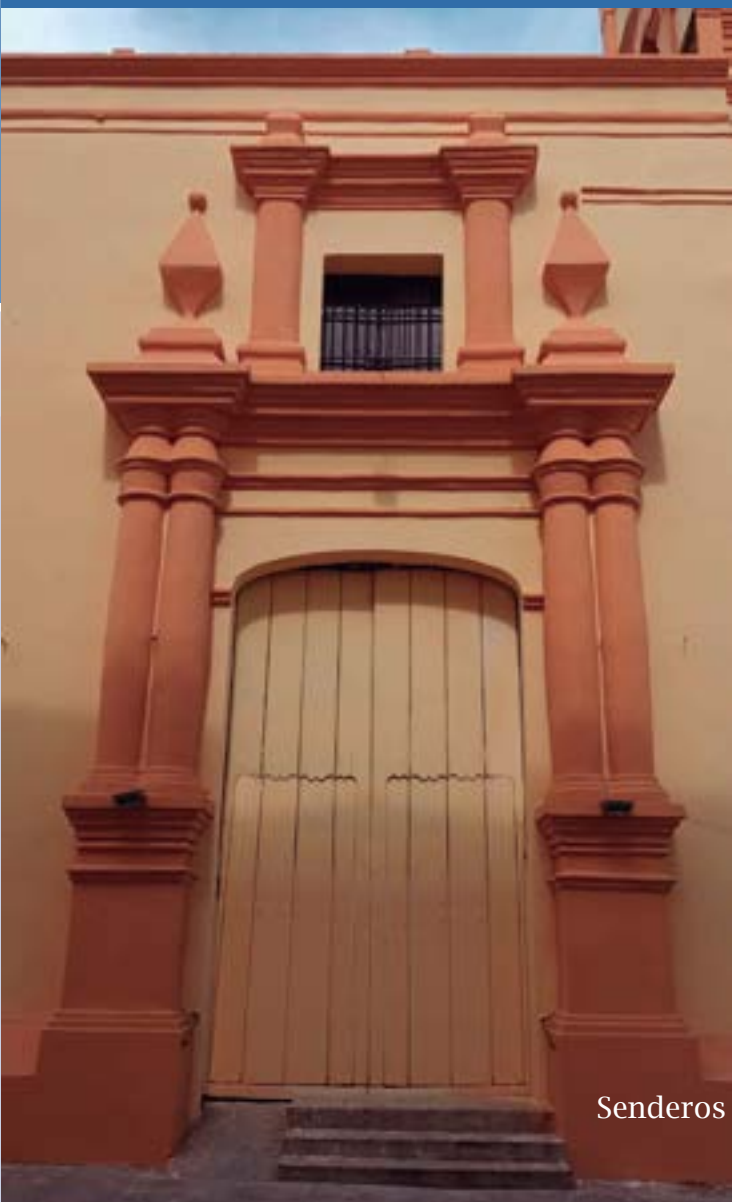
Iglesia de la Soledad, 2023. Puerta de acceso a la nave central desde la calle República.
