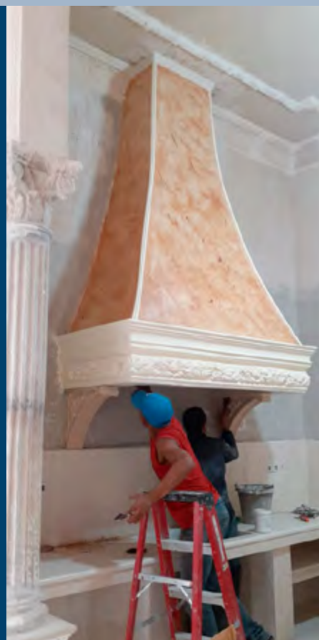
Desarrollo del proceso de restauración
