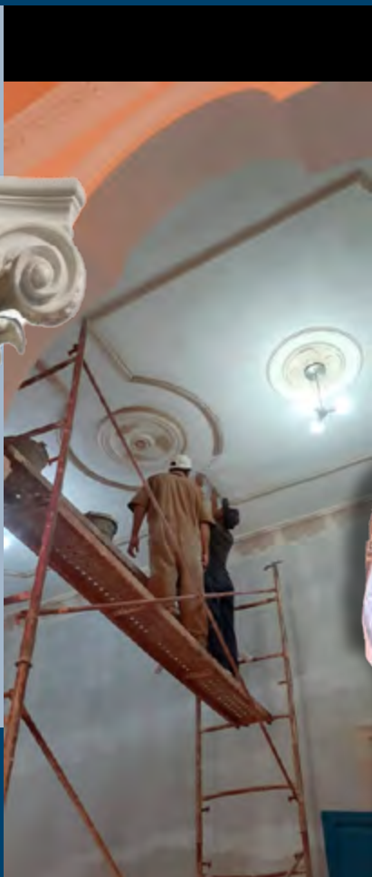
Restauración de techos
